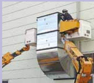
空調ダクト工事
